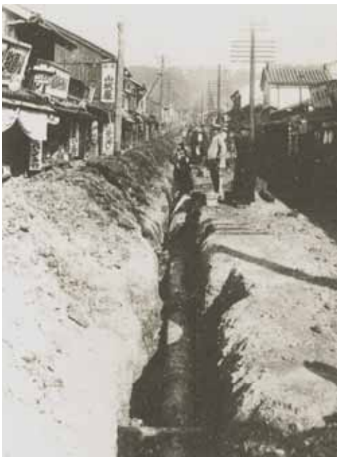
三条通配管工事（大正7年（1918年））
