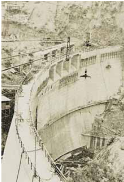
須川ダム建設工事
