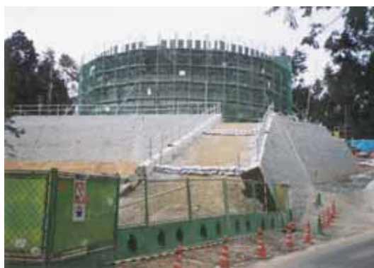
大慈仙配水池築造工事
