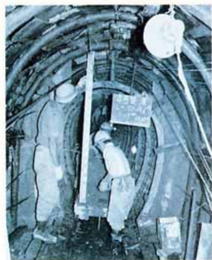
自然流下水源導水路事業 （第 4 号隧道）
